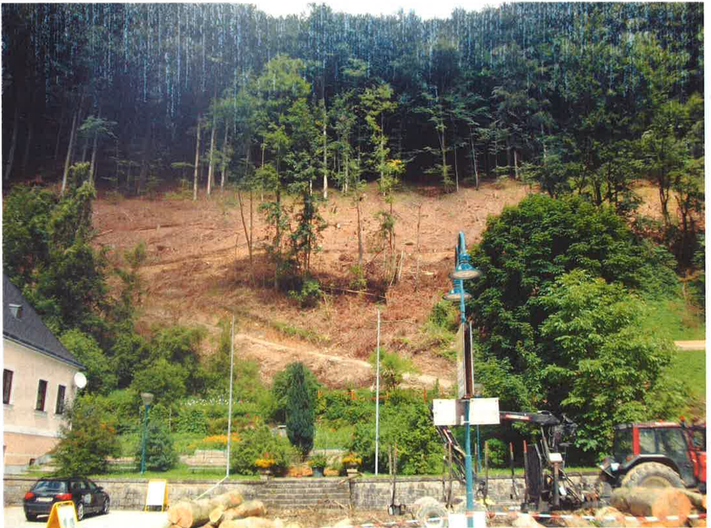
Stein- und Baumschlagsicherung , Kirchenplatz
